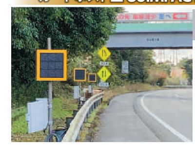
コンパクト化されたガードポスト型USIMPACTは、 ガードポスト取付け型で、設置・撤去作業がガード レール内で実施出来ます。
